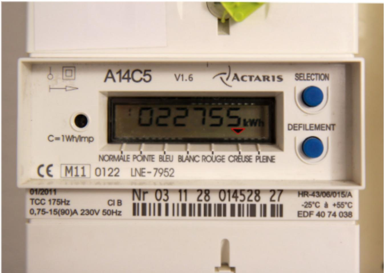
Figure 2.7 Un compteur électronique en tarif heures pleines/ heures creuses
