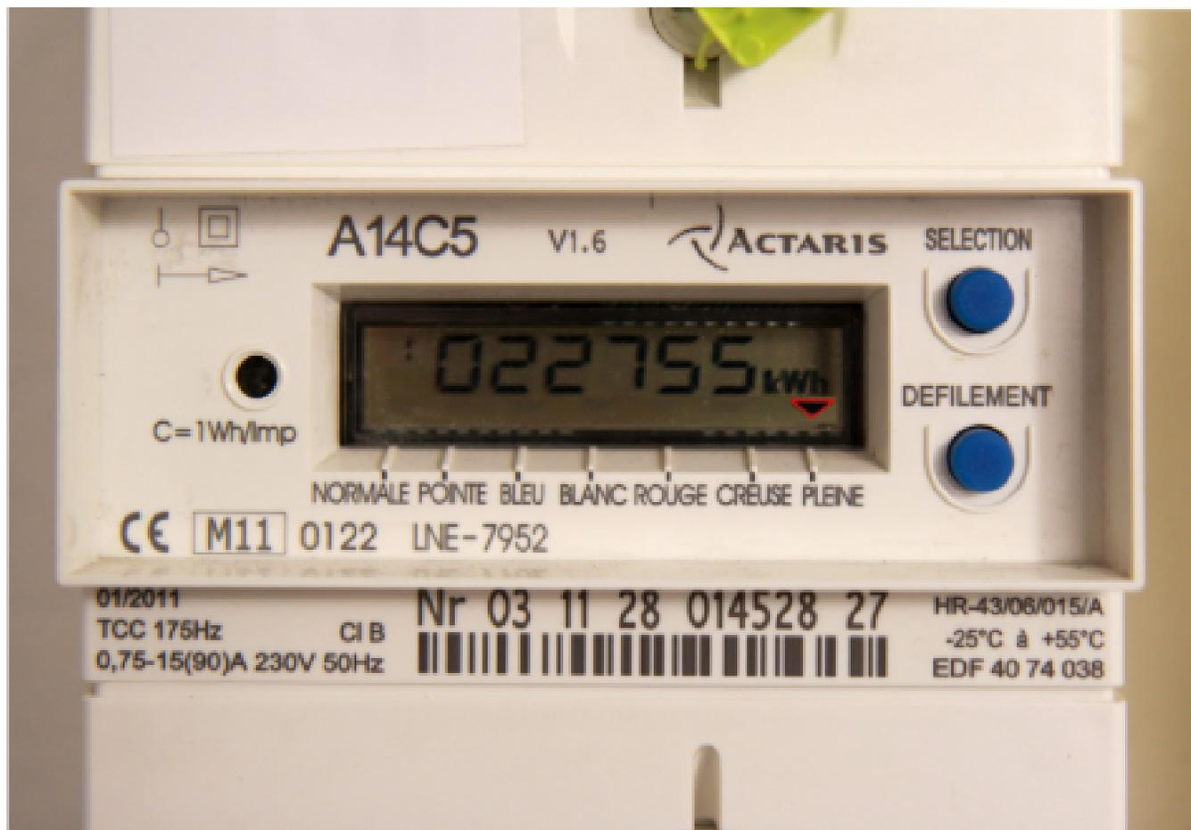
Figure 2.6 Un compteur électronique en tarif de base
