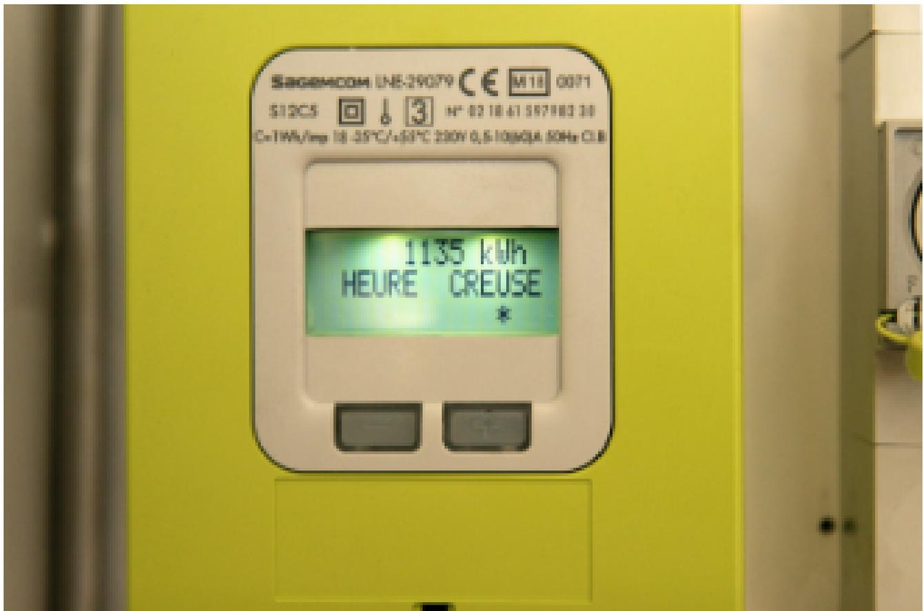
Figure 2.9 - Un compteur Linky option tarif heure pleine / heure creuse
