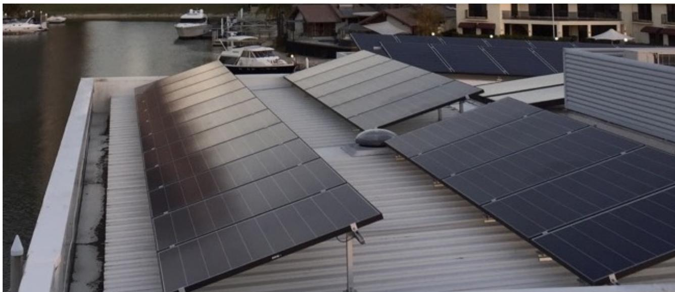
Si vous devez absolument installer des panneaux à plat, alors faites en sorte qu'ils soient sans cadre métallique, uniquement le laminé. Cela facilitera l'écoulement de l'eau à leur surface et réduira la quantité de saletés qui va s'y déposer. Les panneaux solaires sans cadre en aluminium sont plus chers, et doivent être très bien fixés au niveau de leurs bords.
